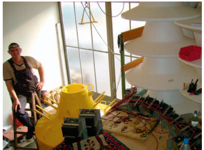
Abbildung 9: Einbau der Batterien mit einer Kapazität von knapp 400 Ah bei 12 V.
