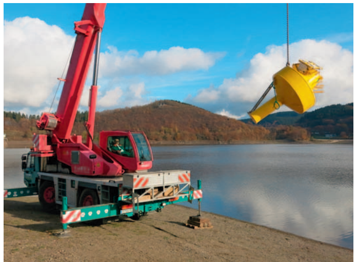
Abbildung 27: Wasserung der Boje an der Biggetalsperre am 20.11.2013 mit Hilfe eines Autokrans.
