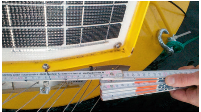
Abbildung 26: Schaden an einem der Solarpanel nach der vermeintlichen Schiffskollision im Zeitraum 14.-15.09.2013, der zunächst durch Eigenleistung wieder repariert wurde.
